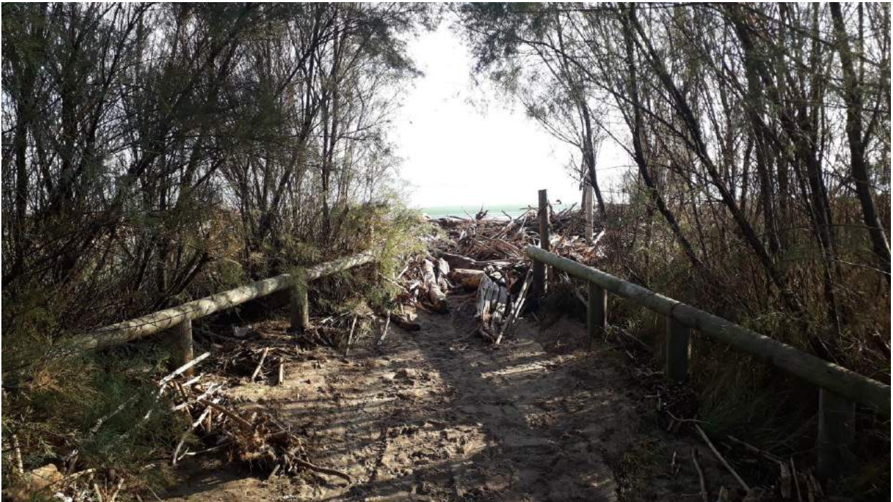
Fig. 1 – Vialeto di accesso alla spiaggia dalla Torre sul porto, occluso dai detriti vegetali depositati dalle onde.
